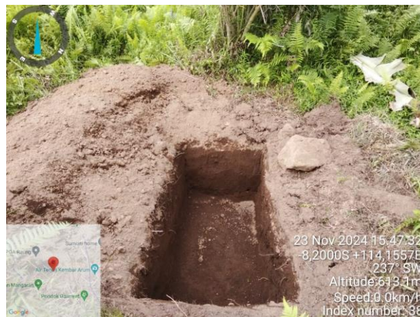
Gambar 1. Pembuatan sumur resapan
